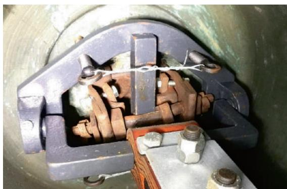
Suspension (à reviser), bélière ferrillée à réparer par soudure
